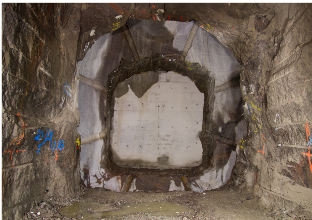
Figur A-2. Bild ifrån slitsuttag med vajersågning från Äspö HRL (Hard Rock Laboratory).
